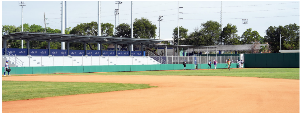
Aspecto del renovado estadio de Estadio de béisbol #3, ubicado en el Centro Olímpico.
