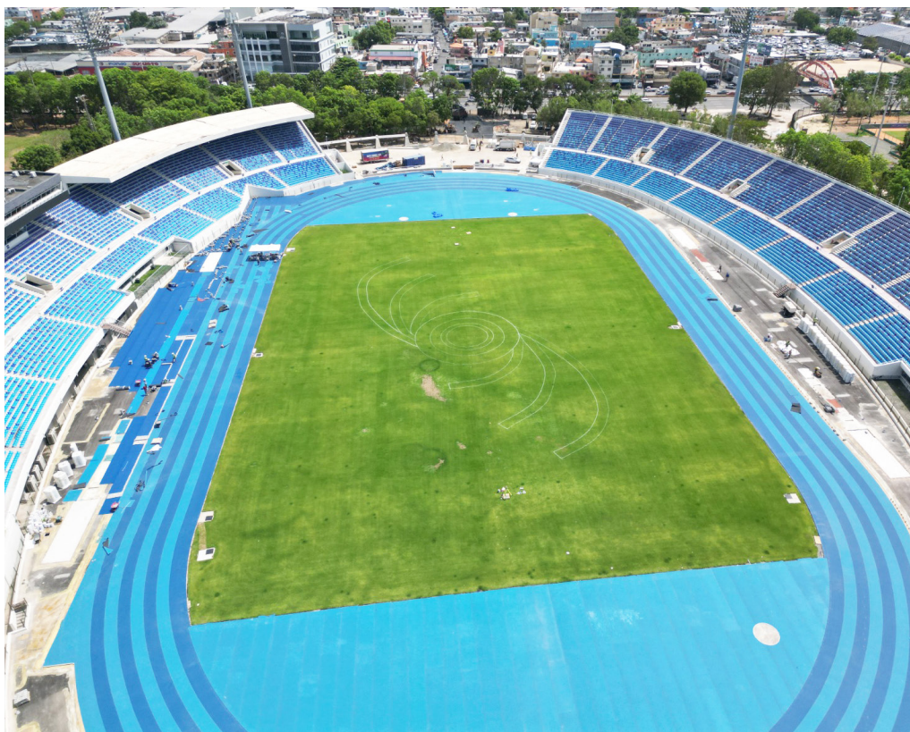
Vista aérea de los trabajos que se realizan en el Estadio Olímpico Juan Pablo Duarte.
