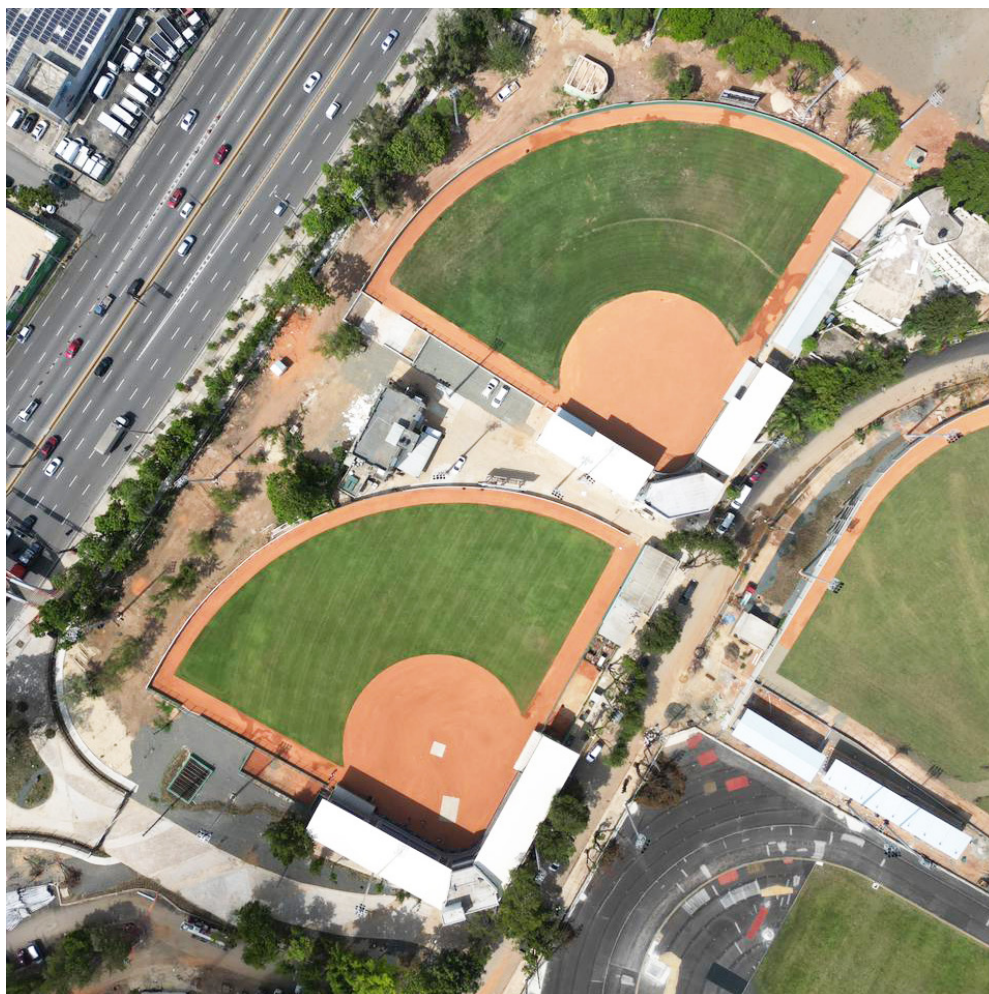
EL estadio de Sóftbol B ahora posee nuevas graderías, vestidores, sistema de drenaje e iluminación LED.
